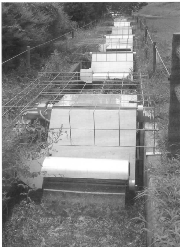
用水路に設置された「マイクロ水力発電」装置
