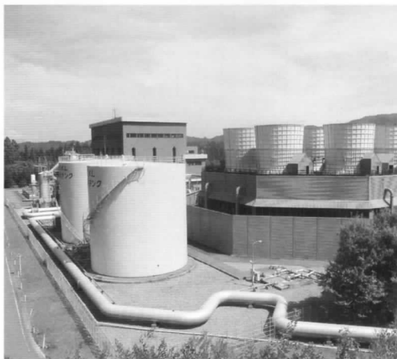
豊富な地熱を利用した「柳津西山地熱発電所」
